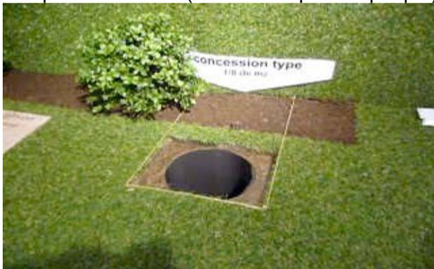
Il équipe chaque trou d'un insert - le plus gros élément du système- et le bloque en terre grâce au système d'ancrage. Temps d'opération par concession : une quinzaine de minutes si le travail est fait en série. Le gazon environnant n'est pas dégradé par l'opération.
